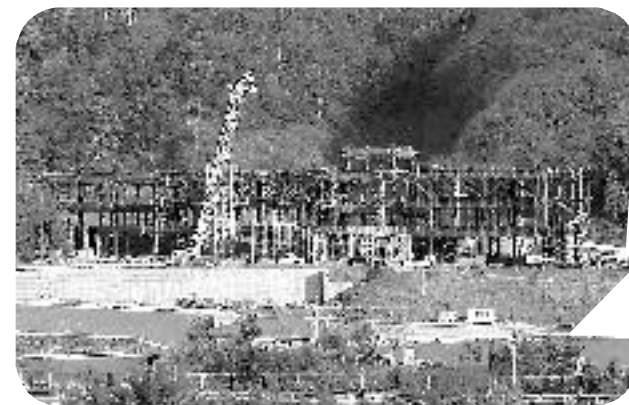
建設が進む市民温泉施設
