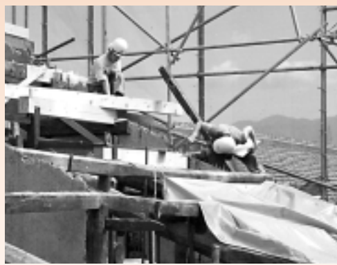
西福寺 書院の屋根修復現場
