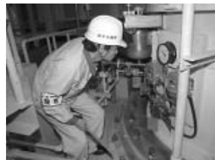
プラント確認試験の様子
