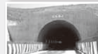
トンネル入口(山区側)
