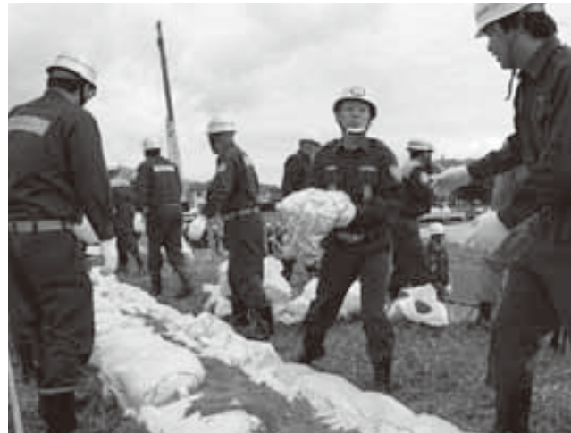
積み土の工法の訓練に挑む参加者
