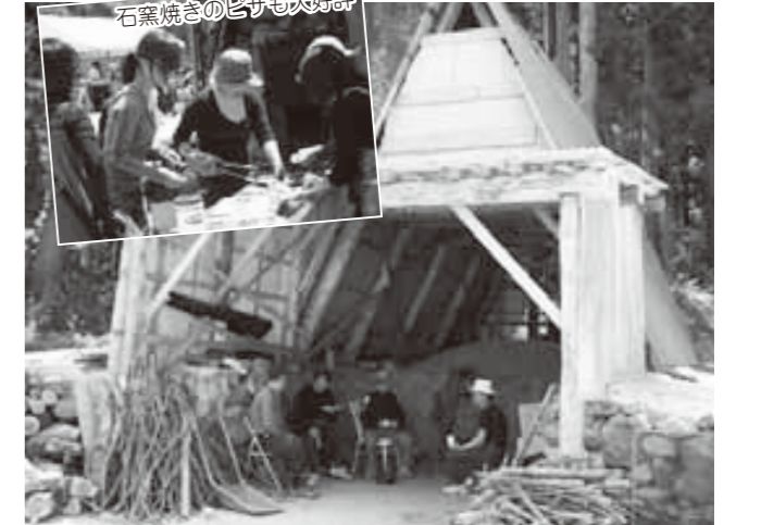
完成した炭焼き窯
