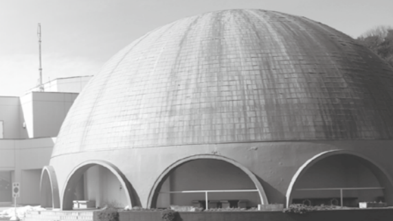
機器設置調整工事中(2月20日現在)
