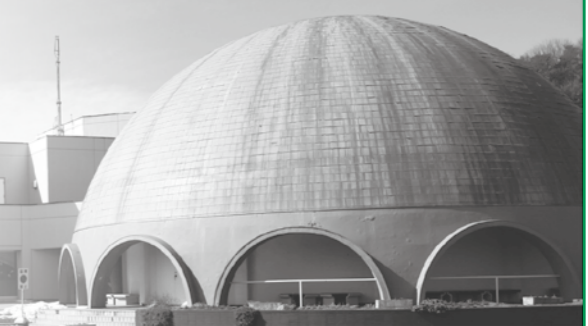
機器設置調整工事中(2月20日現在)
