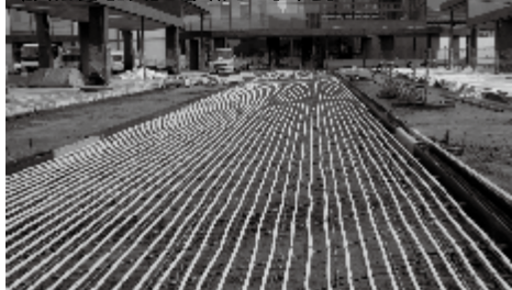
放熱管設置状況 (8月)
