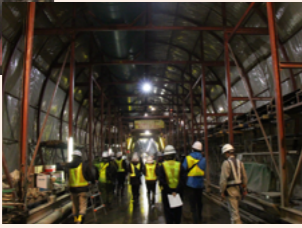
◀トンネル先端の掘削現場
