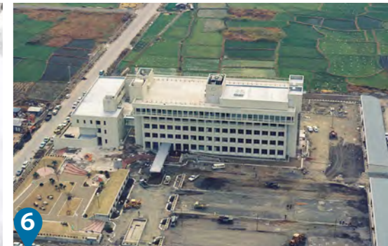
6 建設が進む現在の市役所庁舎
