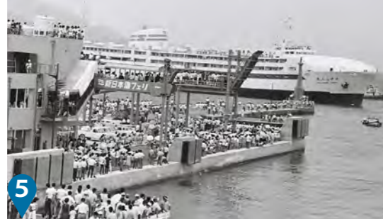
5 川崎・松栄A岸壁に入港する「すずらん丸」
