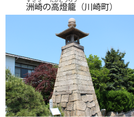
敦賀湊を出入りする北前船の目印として1802年に建てられた石積み灯台
