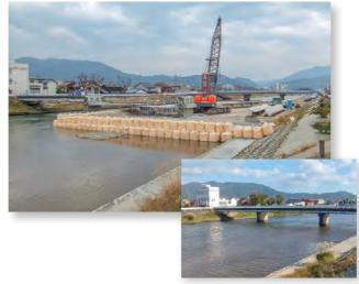
笙の川において、来迎寺橋の橋桁撤去工事が行われています。工事は河川管理者である福井県が実施しており、治水上緊急性が最も高い来迎寺橋の橋桁撤去と仮歩道橋の設置が行われています。笙の川は、平成25年9月の台風18号、平成29年8月の台風5号、10月の台風21号の襲来時に、氾濫危険水位を大きく超え、あと少しで越水するところまで水位が上昇するなど、危険な状況となりました。今回の工事により、必要な河川断面が確保され、増水時における危険性が低減されます。工事は今年の出水期までに完了する予定です。
