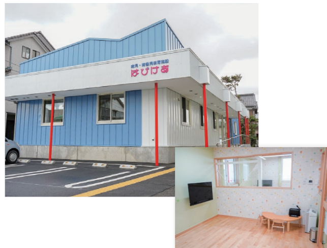
▼施設外観（写真左）と預かった子どもの保育室（写真右下）
