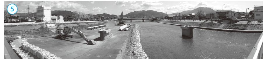
▲来迎寺橋の橋桁全撤去完了後の筥の川 (中央に2つある橋脚は来迎寺橋のもの)
