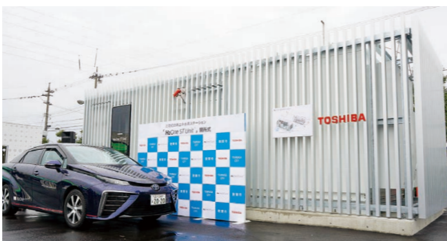
▲公設地方卸売市場内に開所した再エネ水素ステーション
