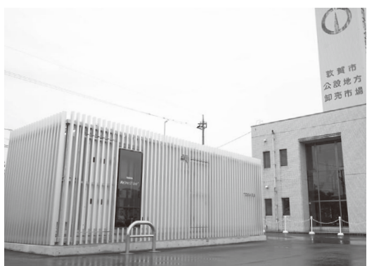
▲敦賀市公設地方卸売市場内に開所した再生可能エネルギー由来水素ステーション
