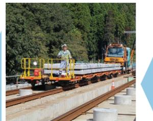
軌道基地に搬入された軌道スラブを敷設箇所まで工事車両で運搬します。
