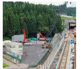
約10～20kmごとに「軌道基地」を設け、軌道材料搬入の拠点とします。現在、樫曲地区に軌道基地を設置しています。
