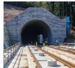
レール送込み装置を使用して長さ200mのレールをコンクリート路盤上に敷設します。その後、軌道スラブを敷設する箇所のレールの幅を3mに拡大します。
