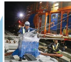
移動プラント車で練り混ぜたCAモルタルを軌道スラブ下面に注入します。
