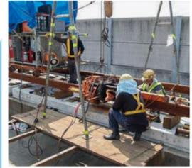
一次溶接と同じ「ガス圧接」で、長さ200mのレールを約1kmの長さになります。その後、軌間・水準・高低・通りを測定し、ミリ単位で調整します。
