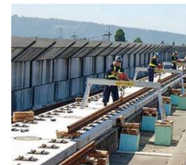
レールを軌道スラブ上に載せて仮締結します。
