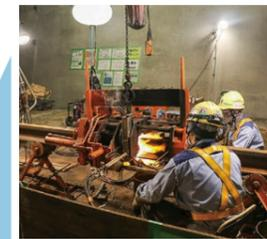
25mのレールを「ガス圧接」という溶接で200mの長さになります。現在、新北陸トンネル内の出口付近で溶接しています。
