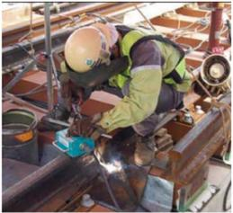
二次溶接したレールを「エンクロズドアーク溶接」で、最終的な長さ（数km～数十km）のレールにします。その後所定の温度でのレール長となるよう調整し、レールを締結し、無事完成です。
