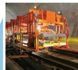
運搬した軌道スラブをスラブ敷設車でコンクリート路盤上に敷設していきます。
