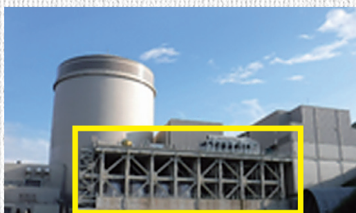
耐震性向上のため安全対策工事で設置した構台
