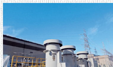
取水口エリアクレーン装置撤去後
