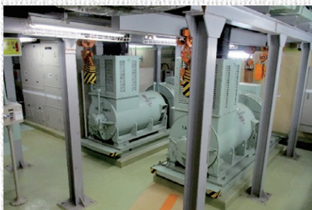
制御棒駆動用電源装置撤去前
