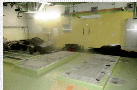
制御棒駆動用電源装置撤去後
