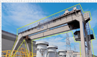
取水口エリアクレーン装置撤去前
