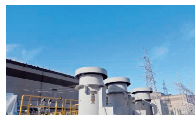
取水口エリアクレーン装置撤去後
