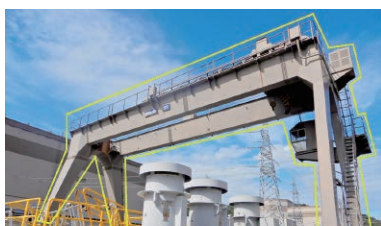
取水口エリアクレーン装置撤去前
