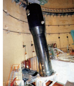
蒸気発生器取り替えの様子
