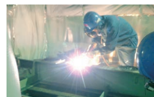
プラズマ溶断作業
