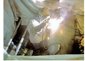
配管取り替えの様子
