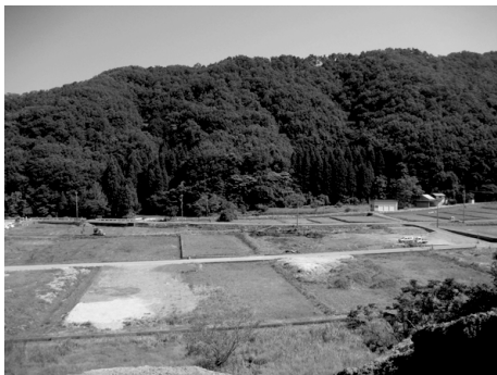
これから造成工事が行われる分譲地B (田結地区)
