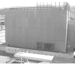
建築中の消防防災館(仮称)
