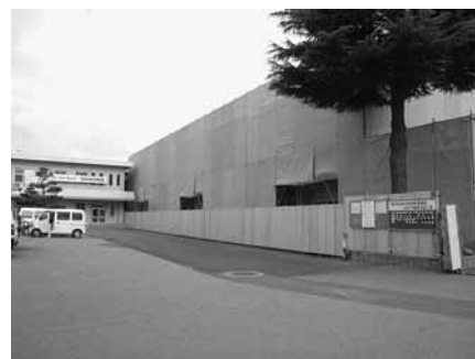
体育館耐震補強工事(気比中学校)
