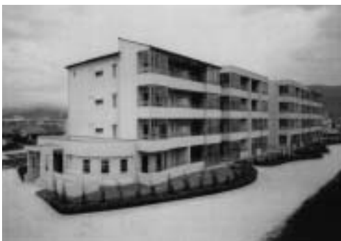
和久野公営住宅
