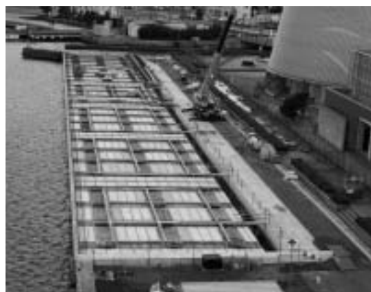
敦賀港耐震強化岸壁（整備中）
