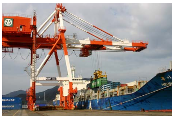
川崎・松栄岸壁
