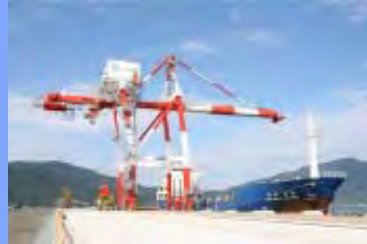
ガントリークレーン
