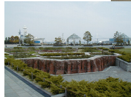
写真：かつての建造物の基礎を復元
