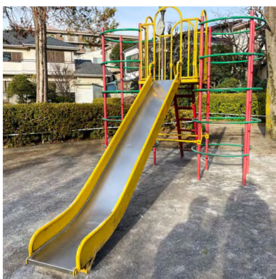
公園遊具の修繕
