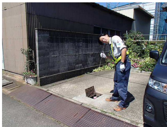
図 3-21 漏水調査
