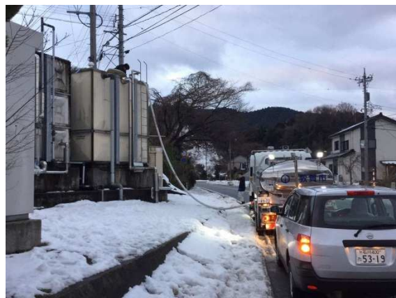
図 3-14 災害支援の状況 （石川県輪島市 H30.2）
