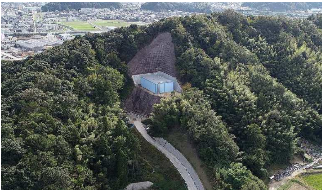
図 5-2 耐震化工事が完了した木崎配水池
