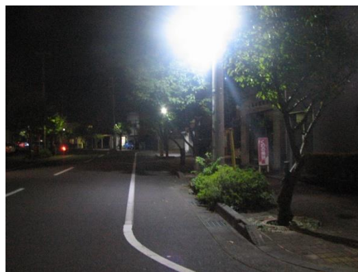
LED 照明（北地区）
