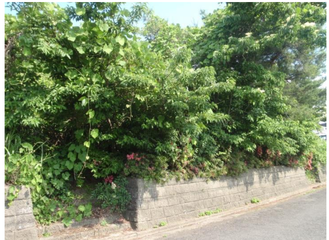
管理不良状態の空き地
