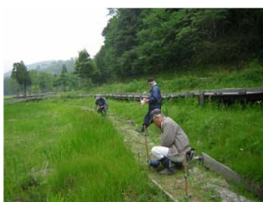
イノシシ対策用電気柵の設置
