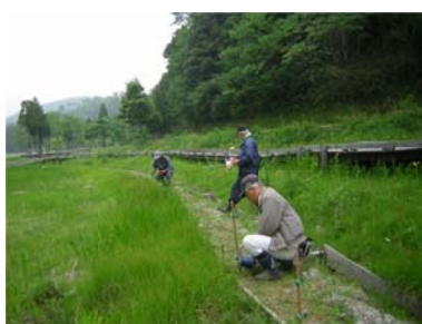
イノシシ対策用電気柵の設置
