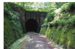
A 行き止まりトンネル(山中トンネル横)
