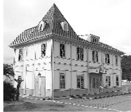
港に新たな憩いの場を (旧敦賀港駅舎)
