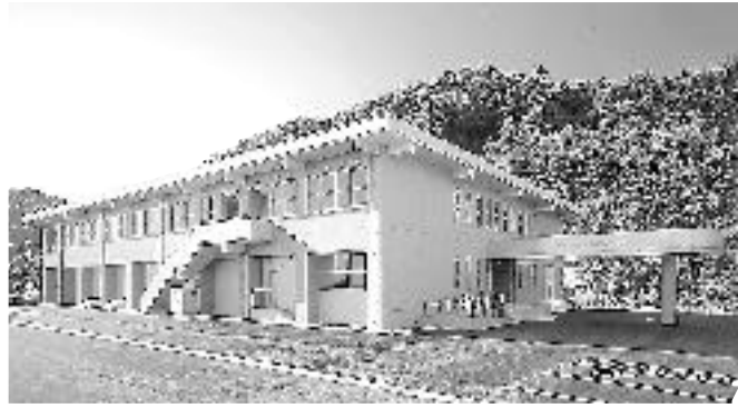
2月に完成した福井県敦賀原子力防災センター（金山）
