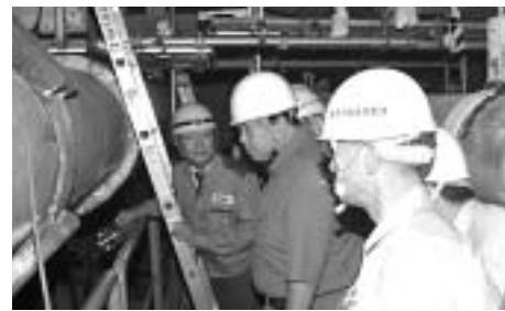
事故現場の確認を行う河瀬市長
