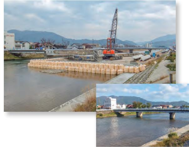
筥の川において、来迎寺橋の橋桁撤去工事が行われています。工事は河川管理者である福井県が実施しており、治水上緊急性が最も高い来迎寺橋の橋桁撤去と仮歩道橋の設置が行われています。筥の川は、平成25年9月の台風18号、平成29年8月の台風5号、10月の台風21号の襲来時に、氾濫危険水位を大きく超え、あと少しで越水するところまで水位が上昇するなど、危険な状況となりました。今回の工事により、必要な河川断面が確保され、増水時における危険性が低減されます。工事は今年の出水期までに完了する予定です。
