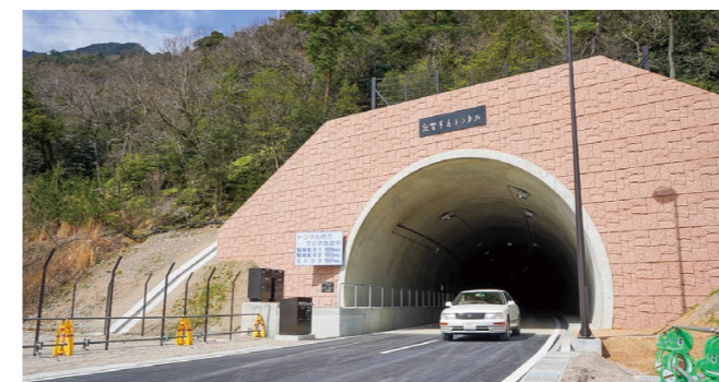
▲開通した敦賀半島トンネル
