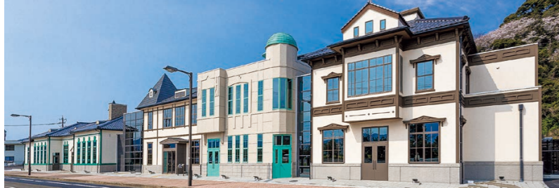
▼大正から昭和初期にかけて実在した建物4棟を復元した 新たなムゼウムの外観
