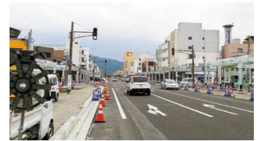
▼歩道橋撤去後
