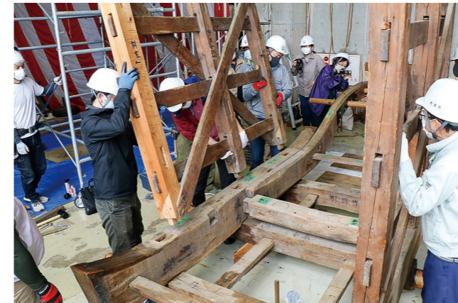
▼解体した唐仁橋山車を組み立てる様子
