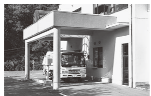
清掃センターのごみ受入窓口
