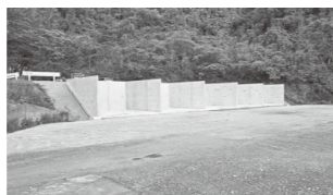
新たな屋外貯留場
