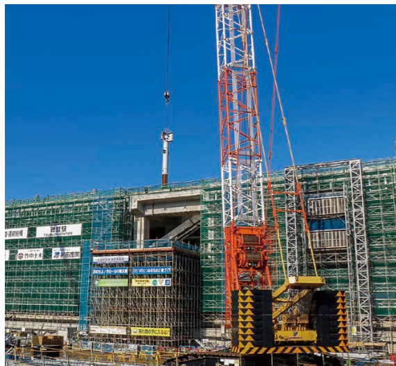
上家の柱となる鉄柱をクレーンでつり上げる様子
