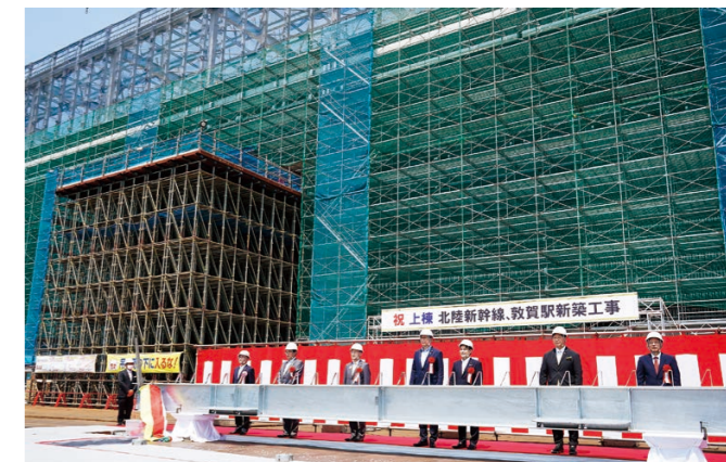
▼最後の鉄骨梁を組み立てる「上棟の儀」の様子
