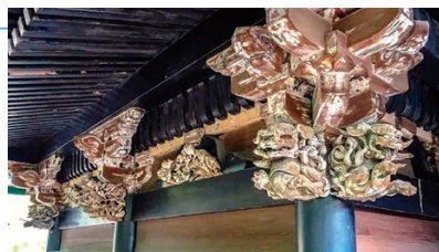
▲本殿組み物の彫刻
