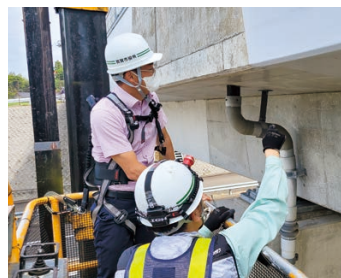
▲橋梁安全点検の様子
