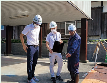
▲下水道工事立会いの様子
