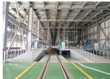
▲ 仕業検査庫(車両基地)
