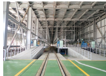
▲ 仕業検査庫(車両基地)
