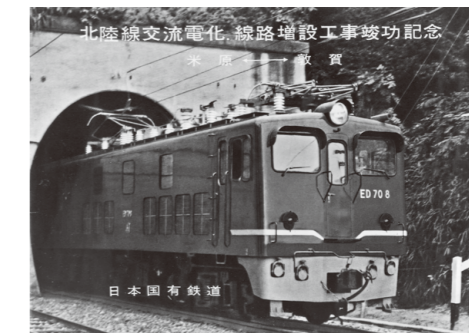
▲北陸線交流電化 線路増設工事竣工記念
